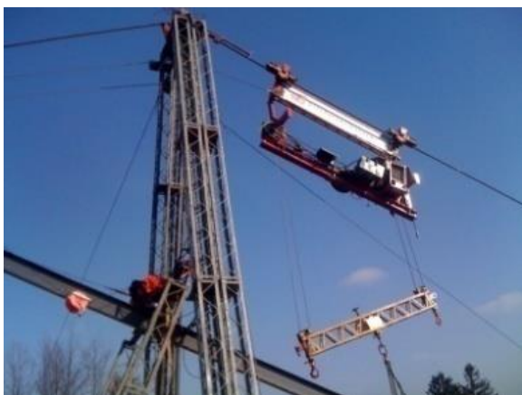
F 40: Laufkatze eines Kabelkrans
