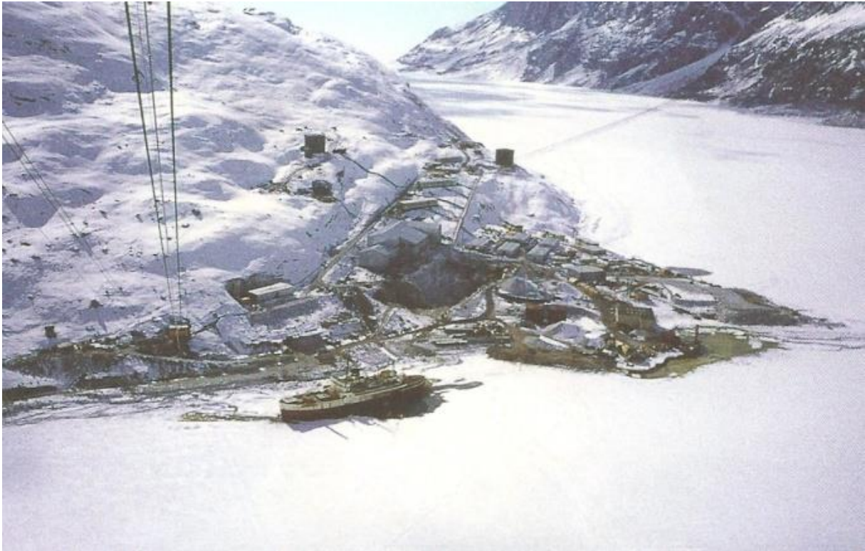
F 78: Die Talstation mit dem Eisbrecher als Wohnraum (RH, S. 141)
