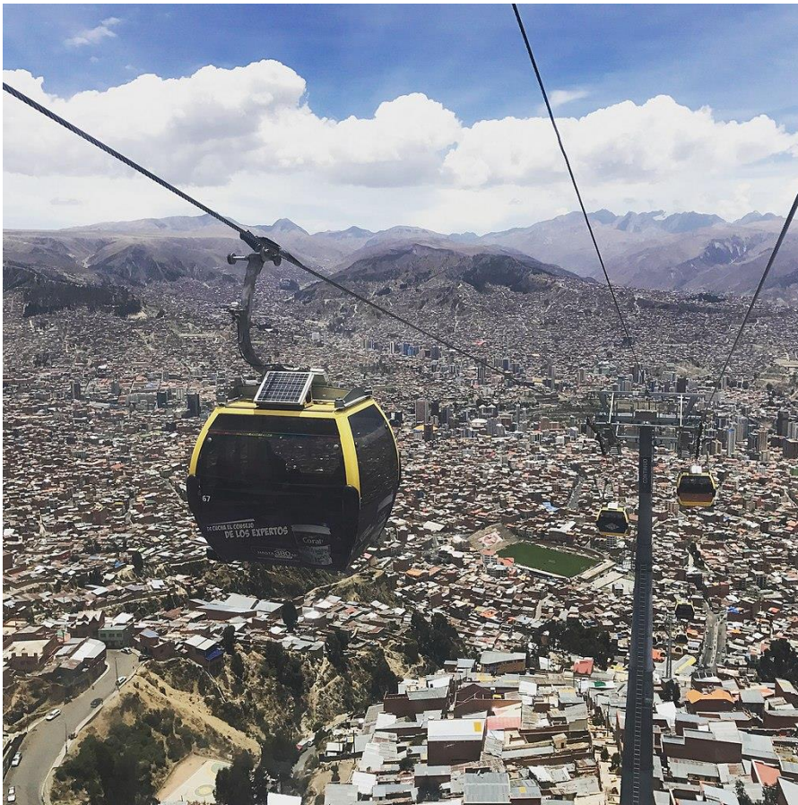
F114: eine Stadtseilbahn in Bolivien (Garaventa)
