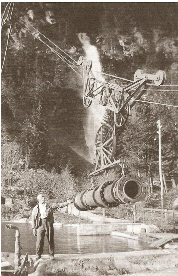
F 33: links verbessertes Holzumlaufseil und rechts F34a: einfaches Transportseil für die Druckleitung Vater Karl und Sohn Karl auf Holzseil und Röhre
