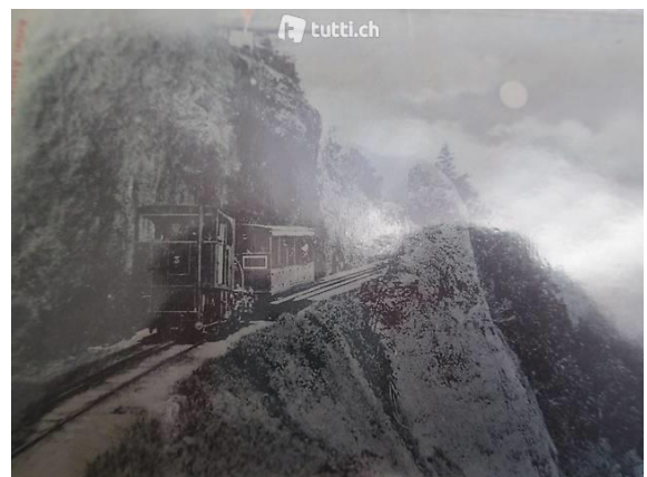
F 7: die Felspartie der Rigi-Bahn bei der Chräbelwand
